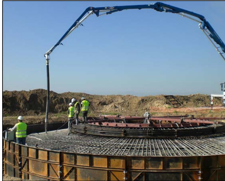
Figure 6 : Exemple de coulage du béton de fondation d'éolienne
